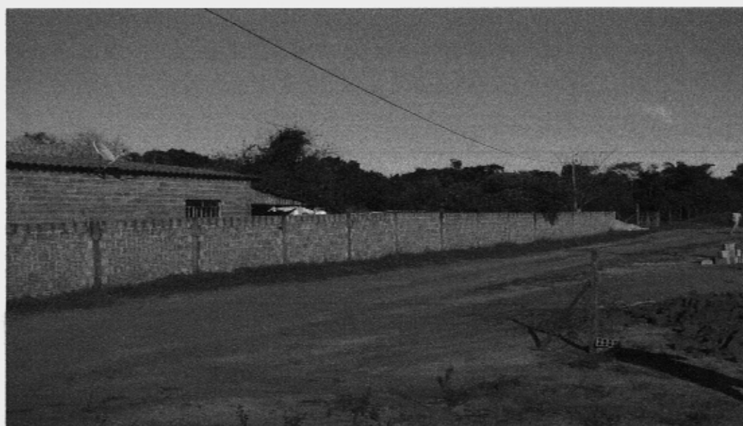
FOTO 02 - VISTA LATERAL DIREITA
