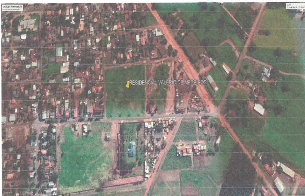
FOTO 01 – VISTA GERAL DO LOTEAMENTO.
