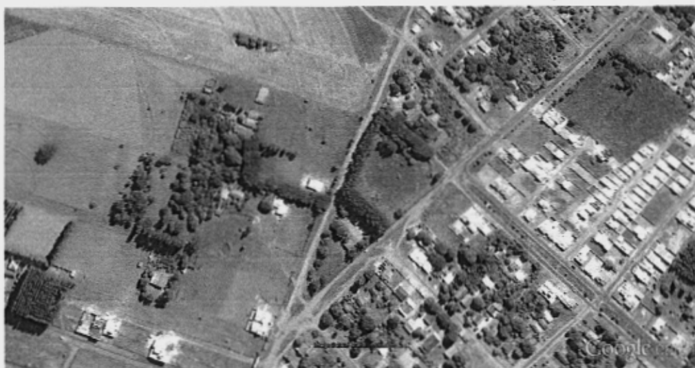
FOTO 01 – VISTA GERAL – Fonte Google
