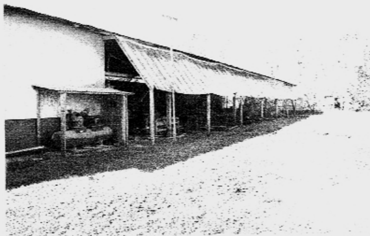
FOTO 03 – Barracão 2 – Vista lateral
