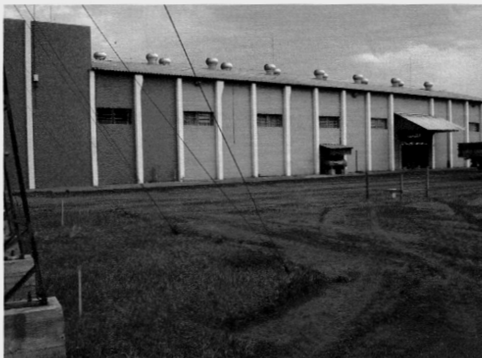
LOCAL DA CONSTRUÇÃO DA AMPLIAÇÃO(FRENTE).
